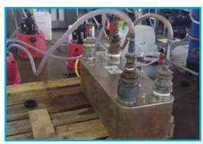
Abgestimmte Reinigungslösungen werden durch den Wärmetauscher gespült und lösen Schmutz und Korrosion.
