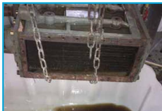
Vor Ort wird der Wärmetauscher von Ablagerungen, wie z.B. Korrosionsschlamm, befreit und gesäubert.
