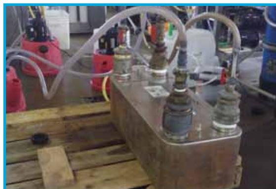
Abgestimmte Reinigungslösungen werden durch den Wärmetauscher gespült und lösen Schmutz und Korrosion.
